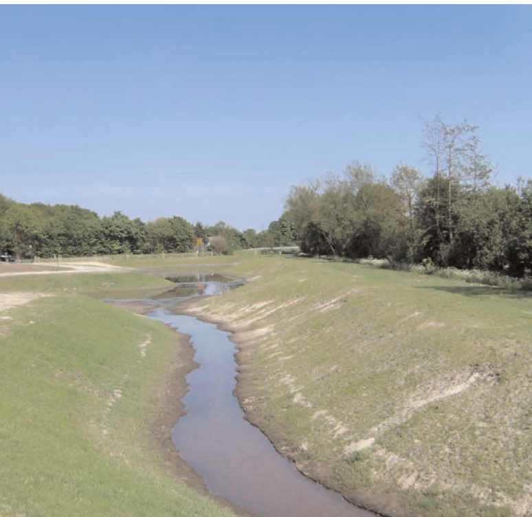
Bild 5: Regenrückhaltebecken Dorfbach mit Restregelmengen
