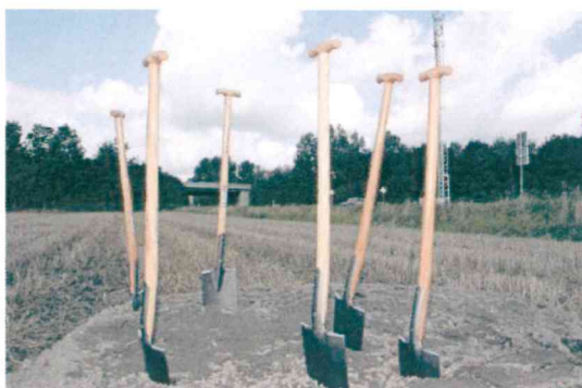
Die Spaten stehen bereit, die Erschließungsarbeiten für das Industriegebiet können beginnen.
