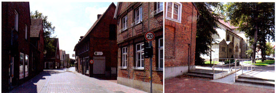
Der Shared Space Bereich in Legden und der barrierefrei gestaltete Zugang zur Kirche (planinvent 2011)
